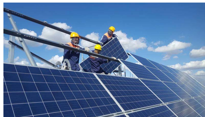
Хөшгийн хөндийн 15МВт нарны цахилгаан станцын нарны панель, баганан суурь суурилуулах ажил
